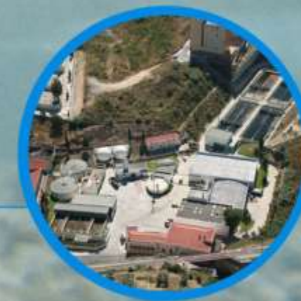
The Chelas WWTP 210000 PE (Portugal)
